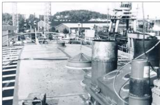
Här har salongernas skylight monterats på det nya aluminiumtaket. Vid sidan av salongernas tak skall ett nytt båtdeck i lärträ läggas.
