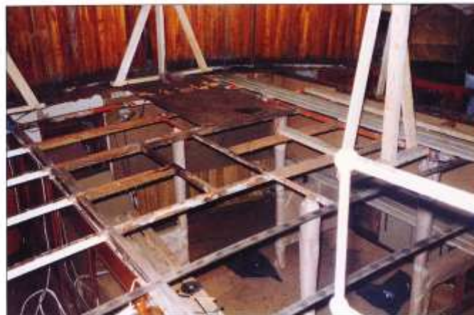
Styrhytten är ilandtagen, bryggdäcket är rivet och man ser ned i röksalongen vars frontskott ännu inte är rivet.
