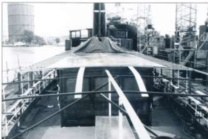
Botensjö med det gamla båtdeckets bostrievet. Nya takbalkar är delvis monterade och salongerna har täckts med ett aluminiumtak.
